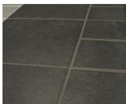
Klinkers i tvättstuga, wc/dusch och bad
